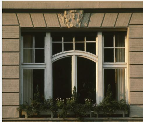
An den einfach verglasten Fenstern bildete sich häufig Schwitzwasser das ganz einfach nach außen geleitet wurde. Heute haben wir isolierverglaste Fenster, die zudem exakt schließen. Es gibt keine „Fugenlüftung“ mehr.
